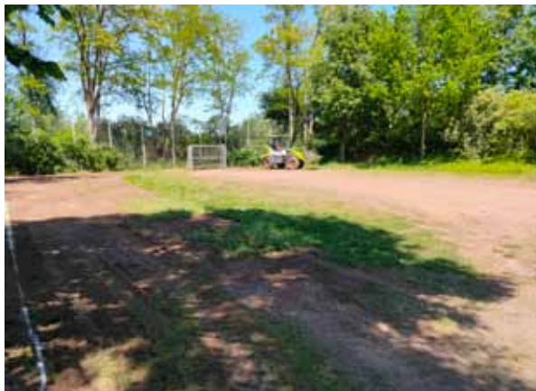
Bagger in Aktion auf dem Bolzplatz Thomas-Mann-Straße Foto: Willi Stenhorst
